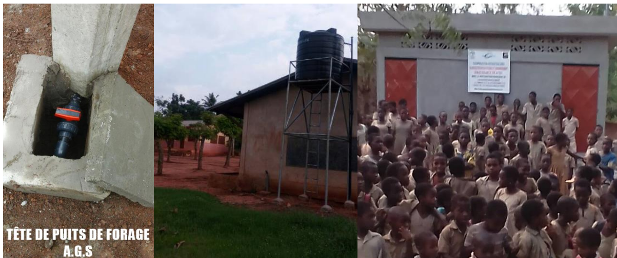
Forage, Château d'eau, Latrines réalisés à Yopé avec le soutien de l'AEAP et St Valéry-Sur-Somme
