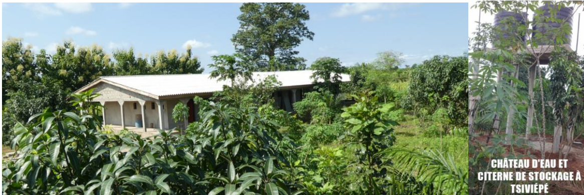
Mise en place d'un Centre Agro-Ecologie avec la construction d'un bâtiment d'accueil des jeunes + forage et
